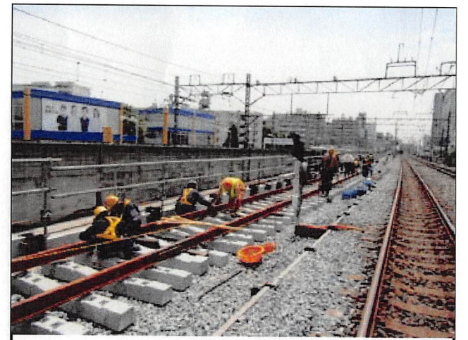
⑪仮線工事状況
