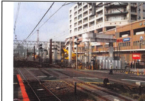
⑦高架橋工事状況
