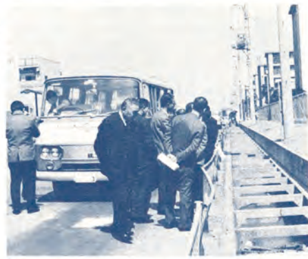
請願された現場(竹の塚地域)をみる土木委員
