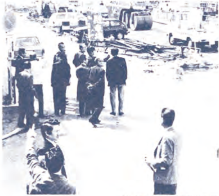
千住新橋の工事現場をみる
