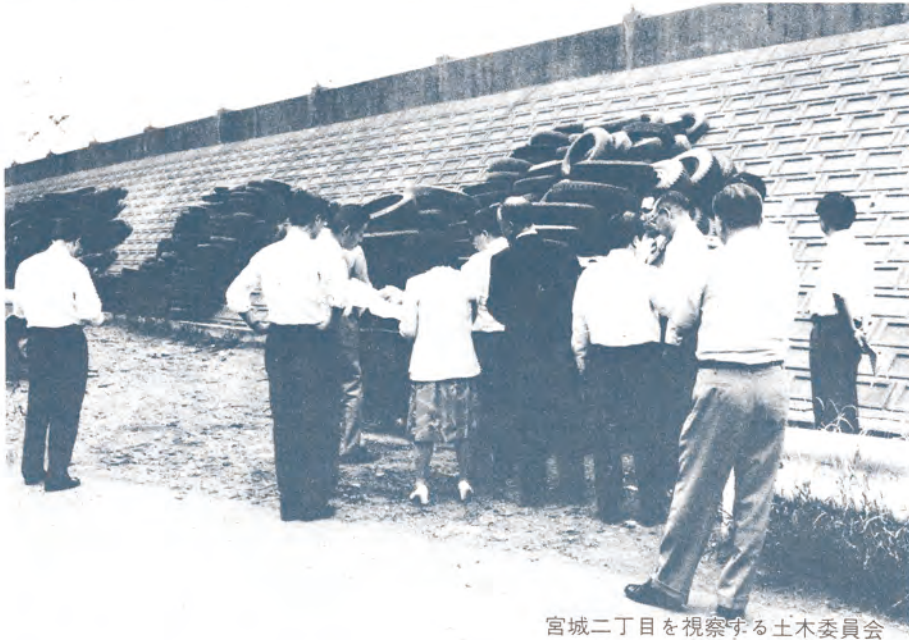
宮城二丁目を視察する土木委員会
